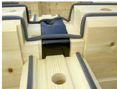
Abb. 4.3: Dichtungsbänder in Blockhausfugen
