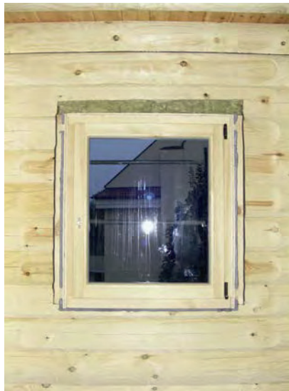
Abb. 4.4: Beanspruchungsfreier Einbau von Fenstern (Bild ohne Dichtungsmaßnahme)
